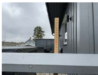
Rekkverket er for lavt i forhold til dagens krav til rekkverkshøyder.
