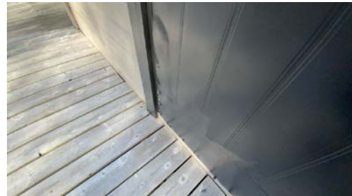
Ytterdør utvendig bod
