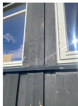
Påbegynnende værslitasje i overflater.
