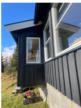
Værslitt/oppsprukket kledning.
