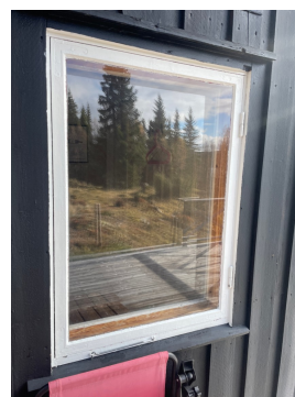
Påbegynnende værslitasje i overflater.
