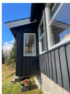
Værslitt/oppsprukket kledning.
