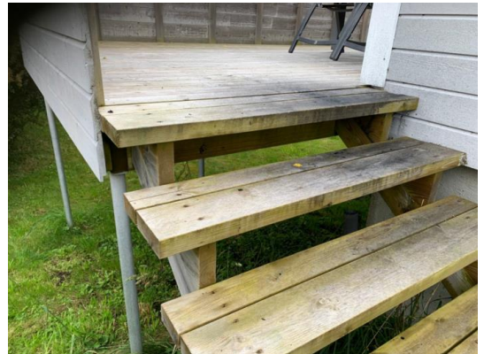
Trapp fra terrasse ved stue ii
