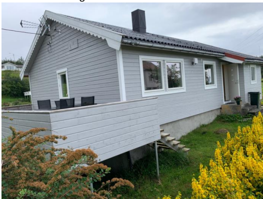
Ny kledning i
