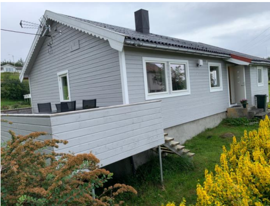
Nyere vinduer i sør-vest / sør-øst
