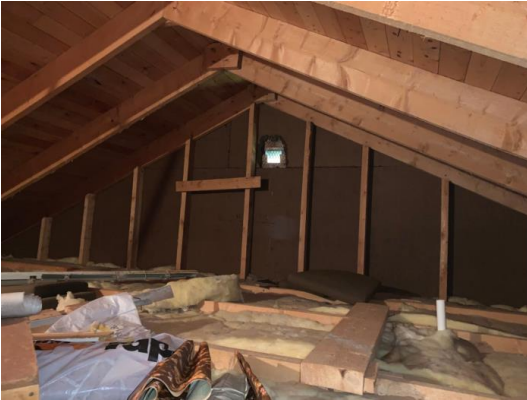
Kaldtloft, mot nord-øst
