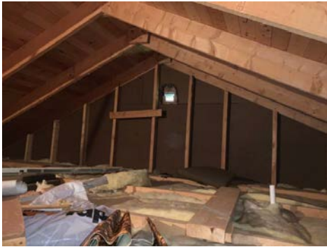
Kaldtloft, mot nord-øst
