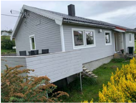
Nyere vinduer i sør-vest / sør-øst
