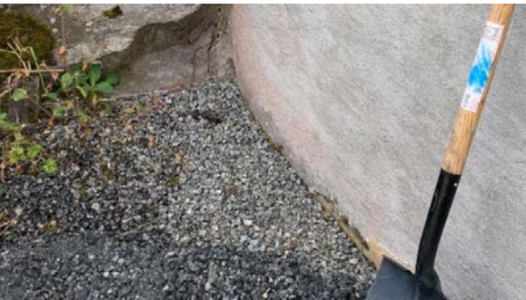
Ringmur av betong - synlig.
