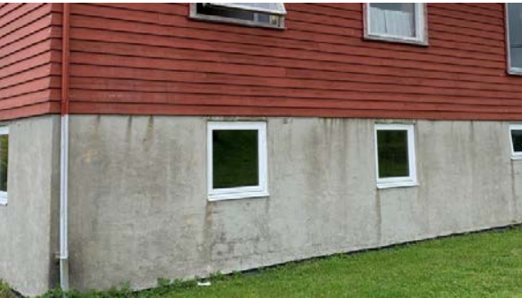
Blæreplast (fuktsikring) mot ringmur ii Årstall: 2003 Kilde: Eier
