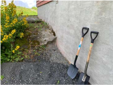
Krypkjellerdel anlagt dirkete på berggrunn
