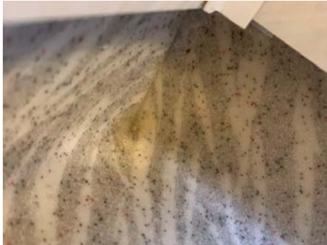
Sammenføyning av vinyl i hjørne fremstår meget bra Årstall: 1992 Kilde: Andre opplysninger: Kilde: Bygningsskalskyndig egen vurdering
