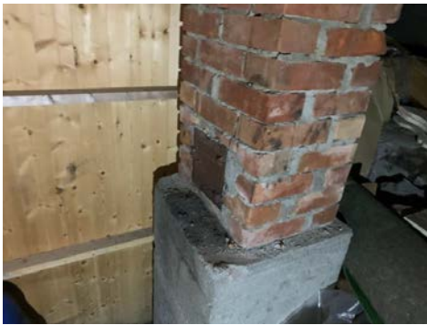
Sotluke i krypkjeller i
