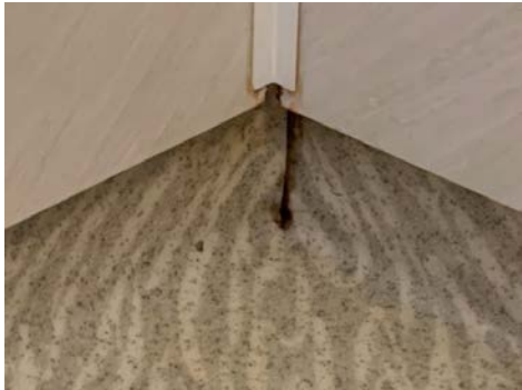
Sammenføyning av vinyl i hjørne ved dusj fungerer meget bra
