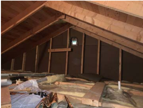
Sperrebind er svake for nedbøyning i undergurt. Evt. lagring primært over rom med god understøtte i innvendige vegger.
