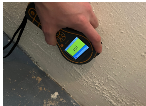
Måling på grunnmur vaskerom
