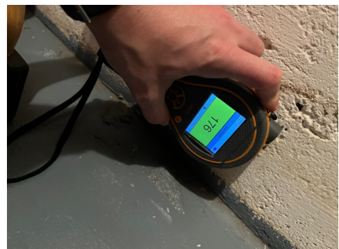
Måling på grunnmur vaskerom
