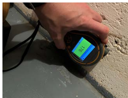
Måling på grunnmur vaskerom
