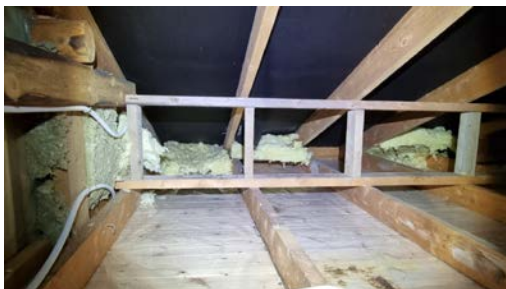
Inspeksjon av kaldloftet.
