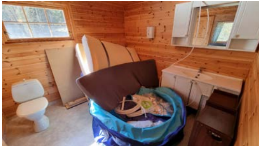
Påbegynt bad i tilbygget del.
