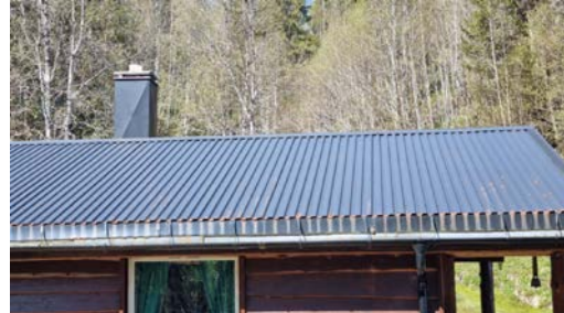
Visuell besiktelse av taket.
