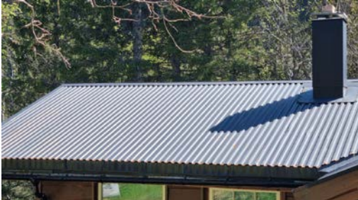
Visuell besiktelse av taket
