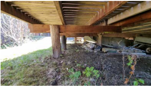
Kontroll av fundamenteringen.
