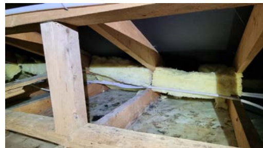
Inspeksjon av kaldloftet.
