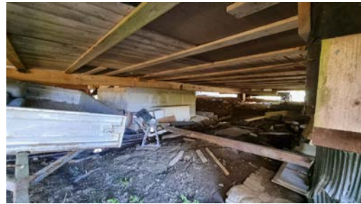
Kontroll av fundamenteringen.
