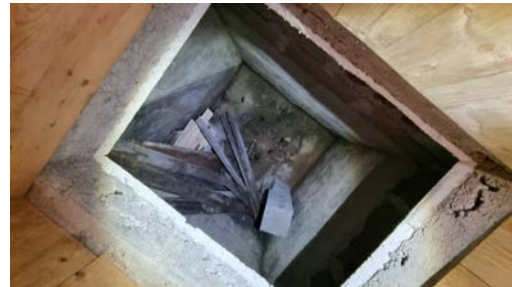
usikkerhet om hva denne konstruksjonen var tiltenkt.
