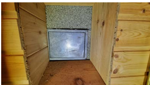
Kontroll av sotluke.
