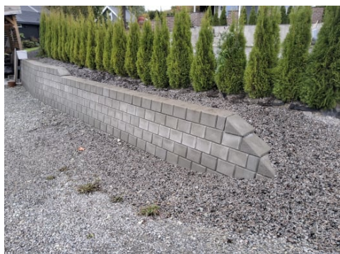
Støttemur i betongblokker.
