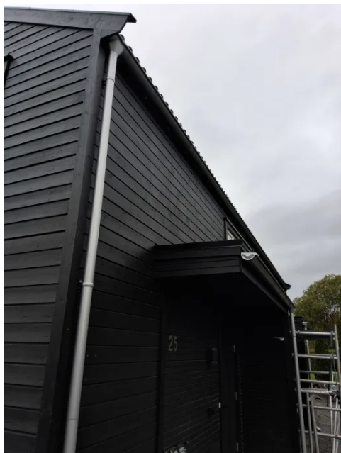
Boligen har renner og nedløpsrør i metall.
