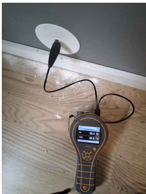
Bilde fra fuktmåling i veggkonstruksjon tilstøtende dusjsone.
