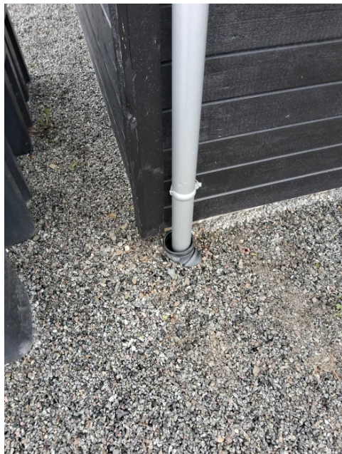
Nedløpsrør er avsluttet i drensrør.
