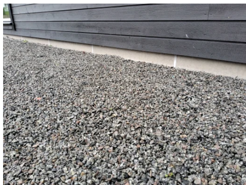
Grunnmur med utvendig platekledning.
