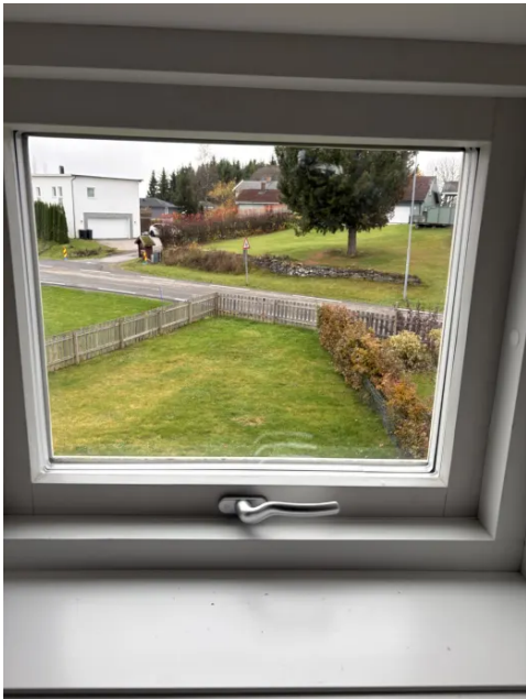
Det er skiftet punktert glass i tre vinduer etter befaringen.
