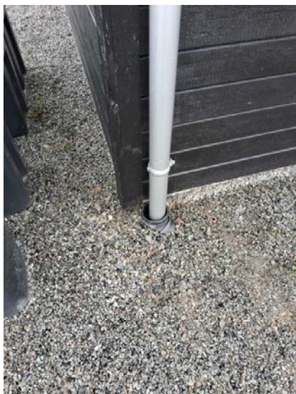
Nedløpsrør er avsluttet i drenerør.
