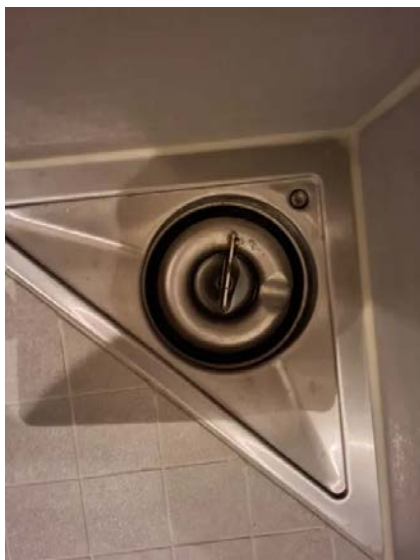
Sluk i rustfritt stål.
