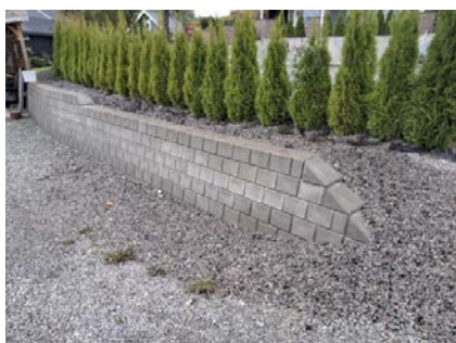
Støttemur i betongblokker.
