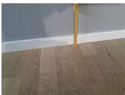
Etasjeskiller er kontrollert med nivelleringslaser.
