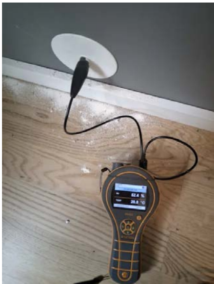
Bilde fra fuktmåling i veggkonstruksjon tilstøtende dusjsone.
