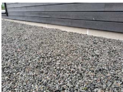
Grunnmur med utvendig platekledning.
