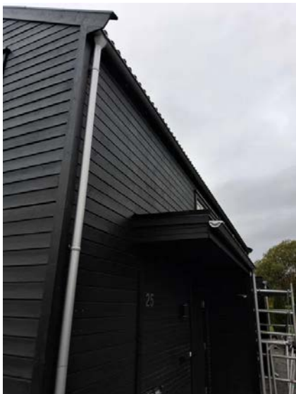
Boligen har renner og nedløpsrør i metall.
