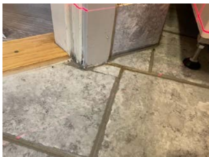
Fuktskade i utforing ved dør.
