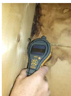
Fuktmåling i undertak viste ingen forhøyede fuktverdier.
