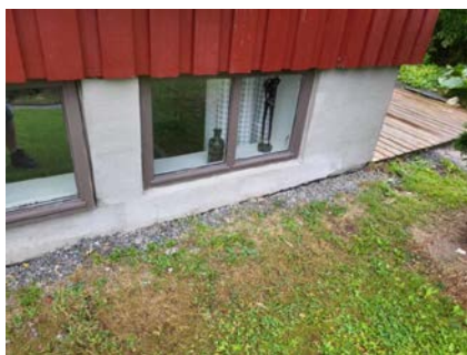
Manglende fuging ved vindu i kjelleretasje.
