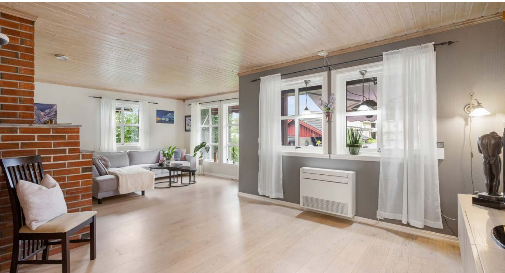
Boligen har også varmepumpe montert i stua
