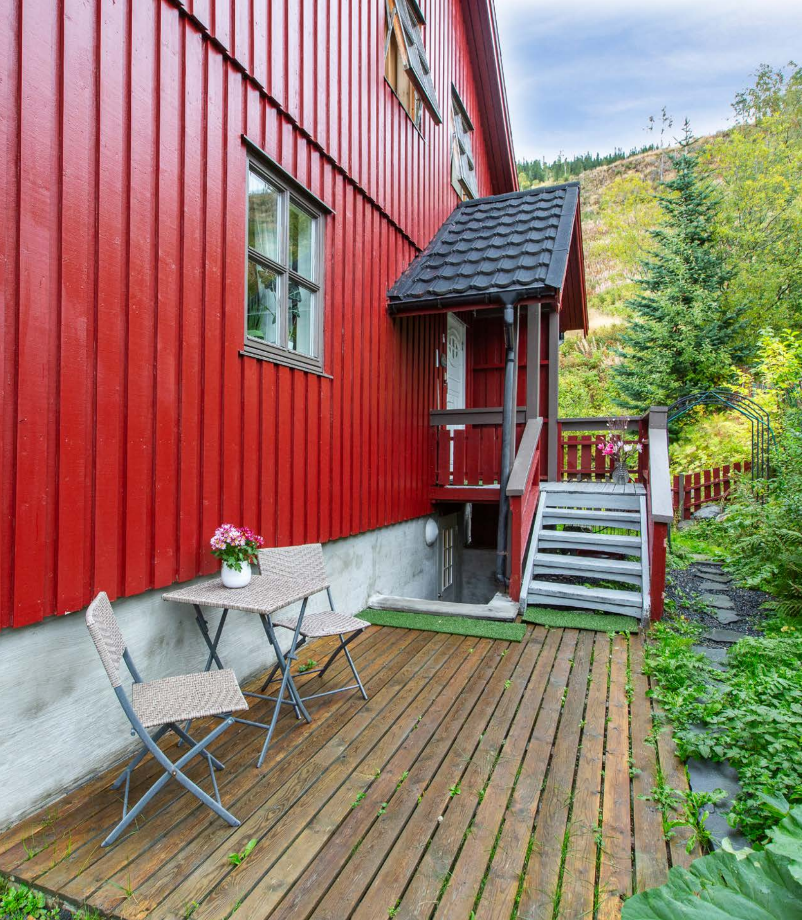
Inngangsparti til både hovedetasje og ned til kjelleretasjen
