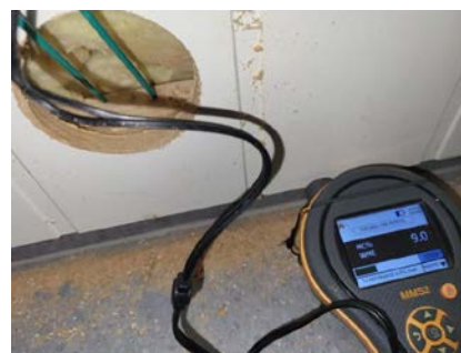
Fuktmåling i utlektet vegg i kjellerstue påviste ingen unormale forhold.
