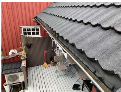
Takrenner av metall.
