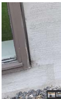
Manglende fuging ved vindu i kjelleretasje.
