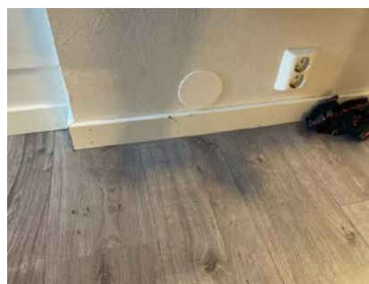
Hulltaking foretatt i gang mot våtsone på bad.
