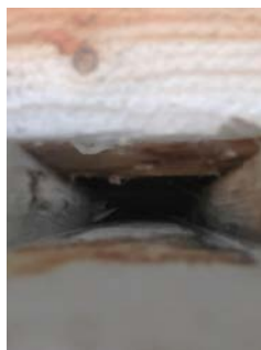
Ingen lusing under bordkledning.
