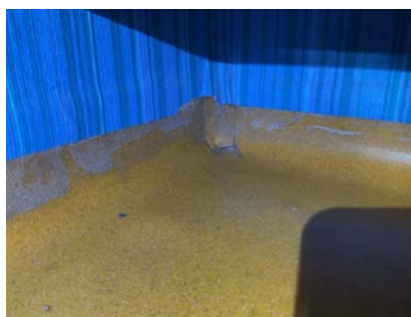
Utett hjørne under innredning.
