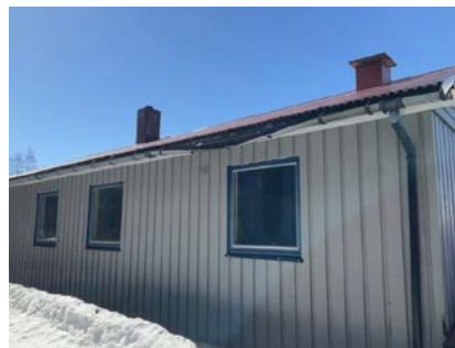
Stor mellom bordkledning.
