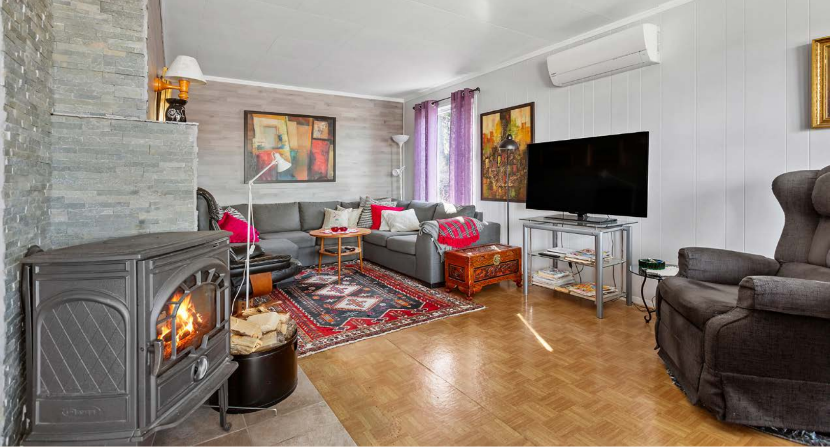
Varmepumpe og vedovn i stua
