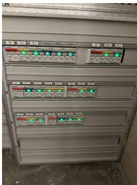
Sikringsskap med automatsikringer.
