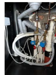
Rørapplegg i kjøkkenbenk med Waterguard
