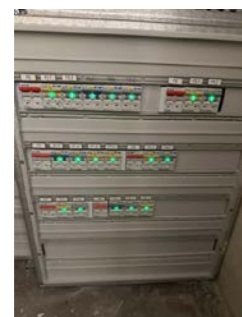
Sikringsskap med automatsikringer.
