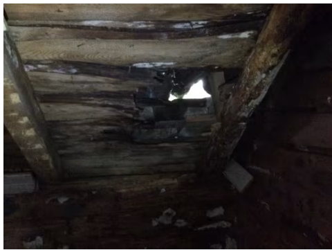
Flere hull og lekkasjer i yttertak.
