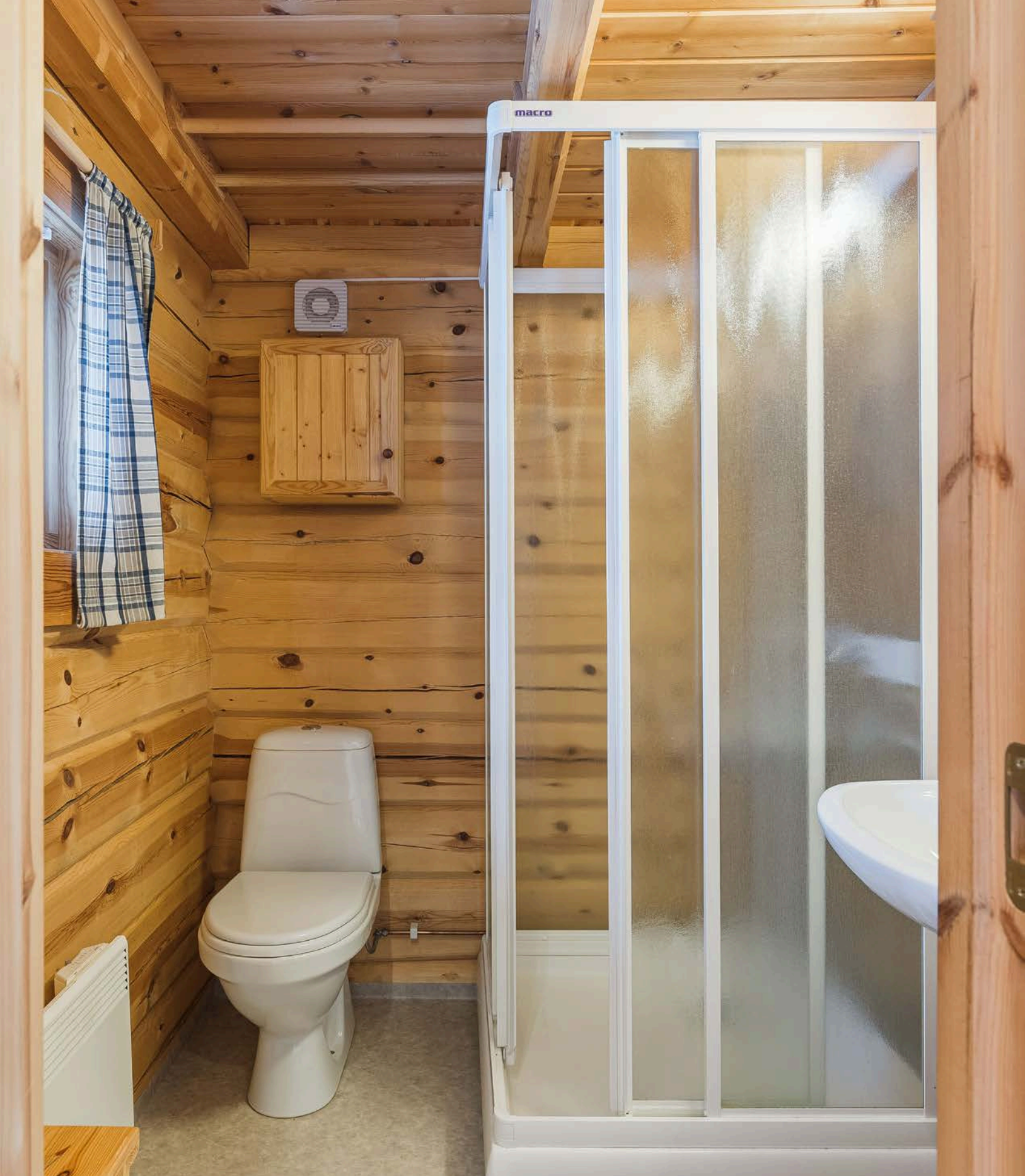
Baderom fra 2004 med våtromsbelegg på gulv, overflater med panel og laftet tømmer, downlights i himlingen og elektrisk styrt vifte. Baderommet er utstyrt med servant, dusjkabinett, toalett og panelovn.
