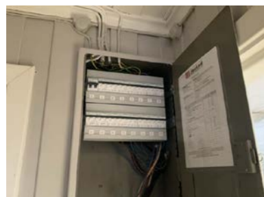
Sikringsskap loftetasje. Gammelt sikringsskap med nyere automatsikringer. Sikringsskap kjeller.
