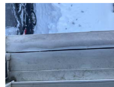
Glipper mellom utforing og vindusramme.
