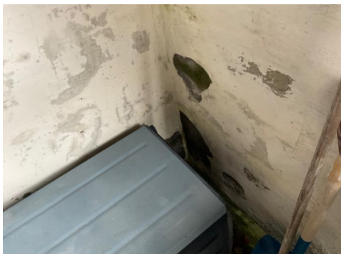
Avflassing av grunnmur
