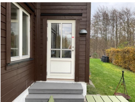
Terrassedør fra biblioteket
