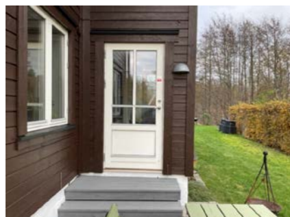
Terrassedør fra biblioteket
