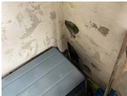
Avflassing av grunnmur
