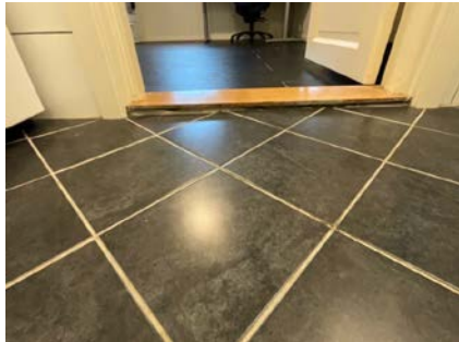
Avslutning mot dørtersel
