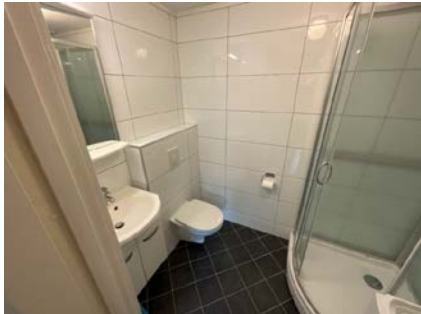
Bad/vaskerom i kjeller
