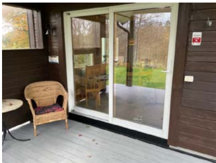
Skyvedør fra kjøkkenet
