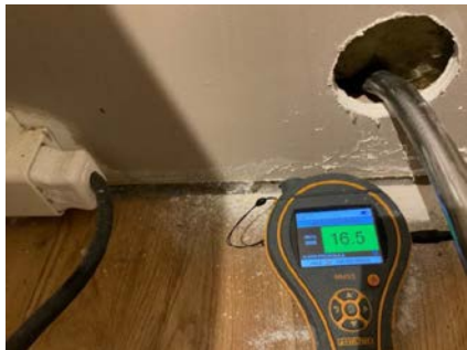
Hulltaking på kjøkken i leiligheten
