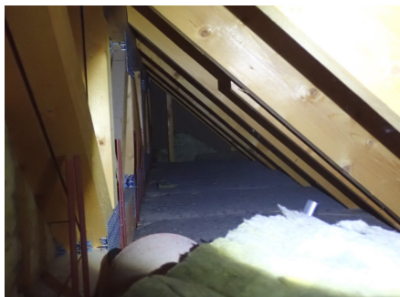
Oversiktsbilde, loft over kjøkken/spisestue.
