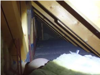
Oversiktsbilde, loft over kjøkken/spisestue.
