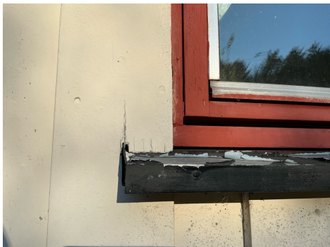
Viser avlassning av beslag.
