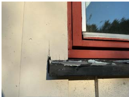
Viser avlassning av beslag.
