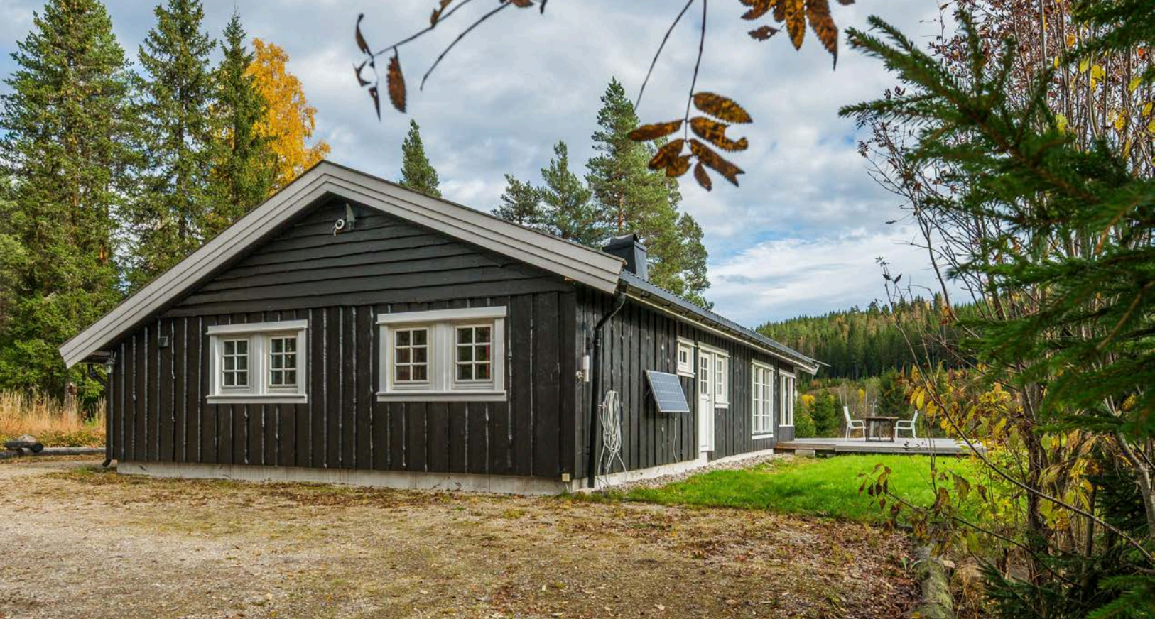
Montert gassvannvarmer i utvendig bod. Montert solcellepanel på yttervegg. 12 volt. Styringspanel i innvendig bod. 220 volt på enkelte punkter. Aggregat plassert i uthus.
