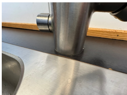
Delaminering ved kjøkkenkranen.
