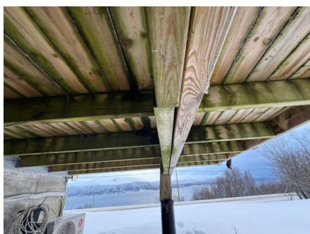
Drager som er skjøtet mellom søylene.
