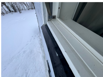
Eksempel på skadet beslag.
