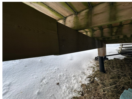
Drager som er skjøtet mellom søylene.
