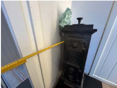
Avstandend til brennbart materiale.
