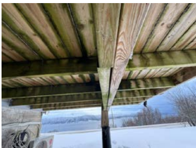
Drager som er skjøtet mellom søylene.
