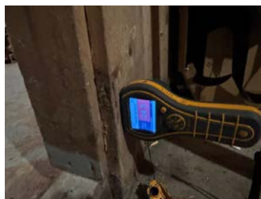
Fuktmåling i trevirke.
