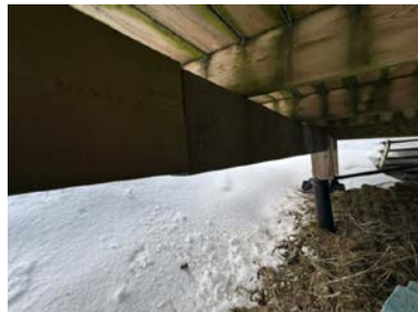
Drager som er skjøtet mellom søylene.
