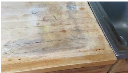
Fuktskadet benkeplate.
