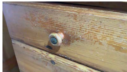
Slitasje på fronter.
