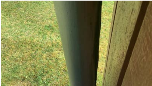
Frostsprenget nedløpsrør.
