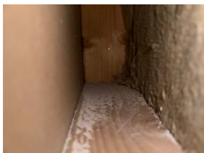
Bilde fra innside vegg
