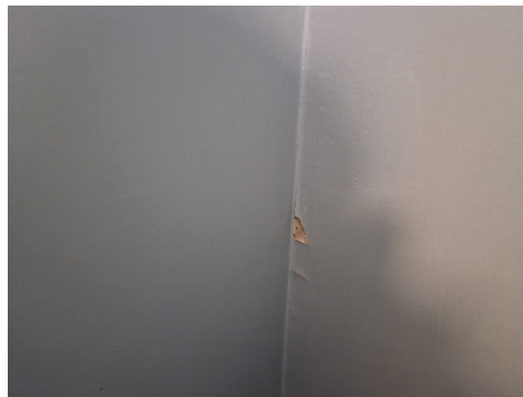
Bildet av sprekkdannelser i hjørnet i dusjens våtsone.
