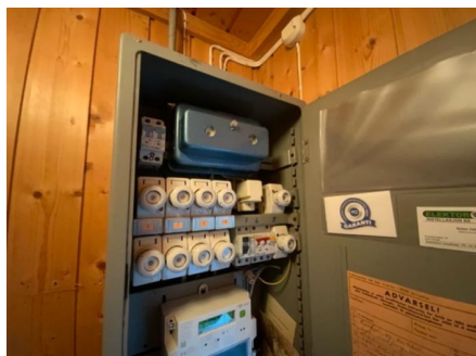
El-skap med skrusikringer.
