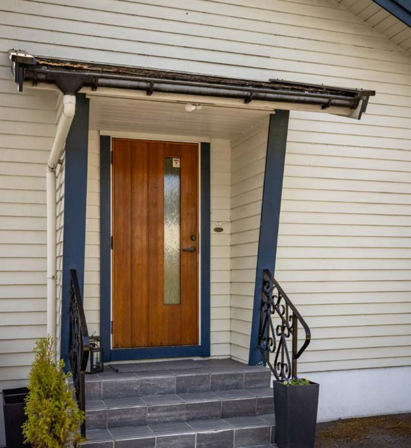
Delvis overbygget inngangsparti
