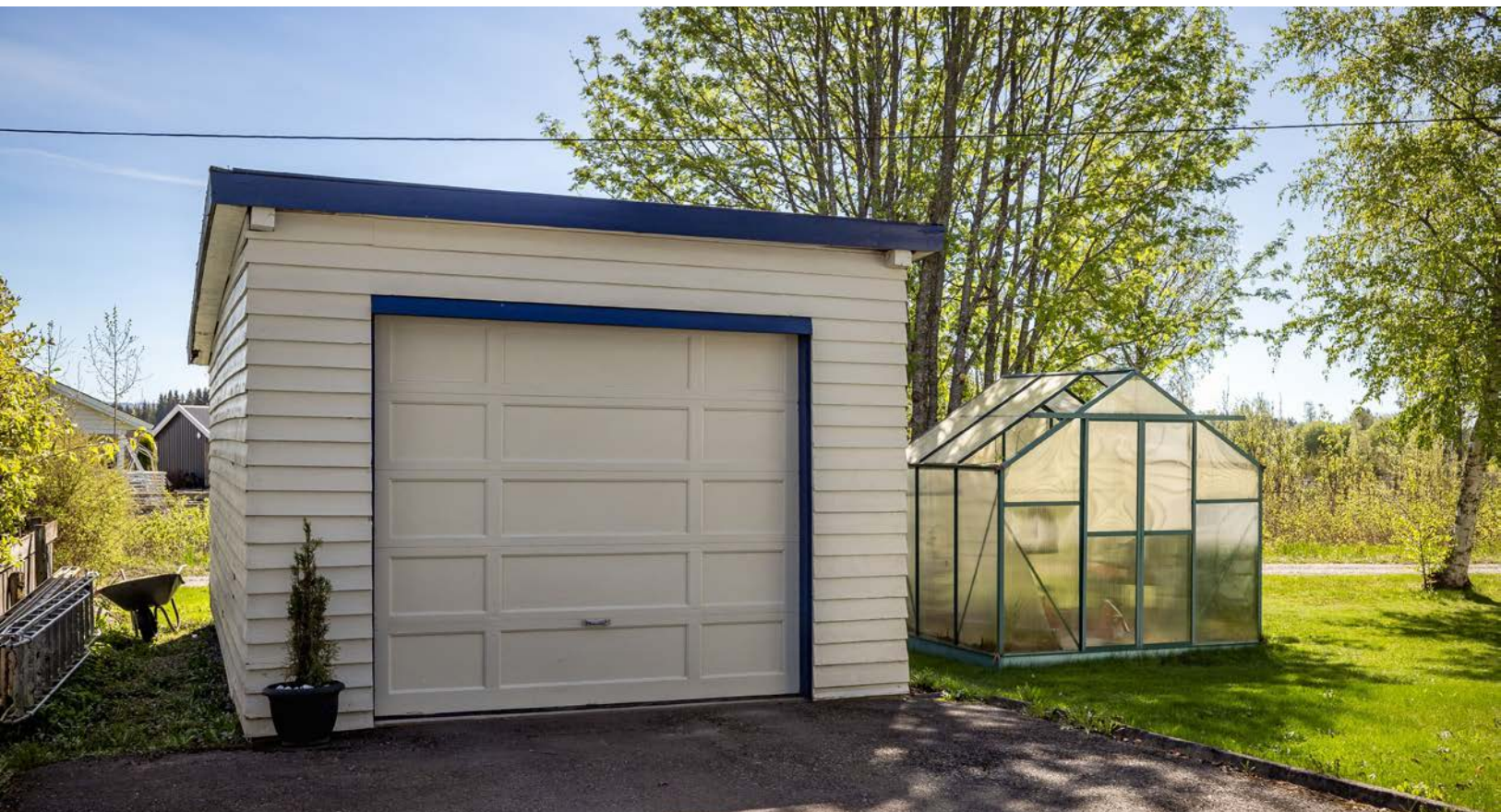
Enkel garasje med elektrisk port.
