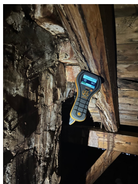
Fuktmåling i trevirke med fuktmerker viste ca. 11 %, som er normalt.
