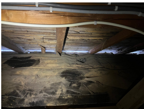
Spor etter borebille på loftet.
