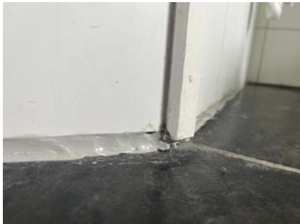
Baderomsplater er fuget i nedkant og trelist i utv. hjørne.
