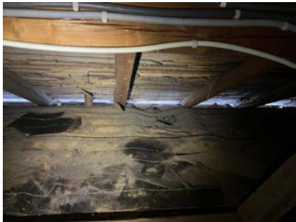
Spor etter borebille på loftet.
