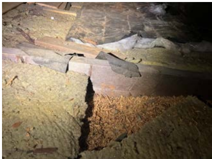
Varierende isolering på loftet.
