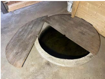
Brønn med vann fra ile i kjeller.
