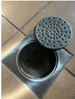
Slukrist over eldre sluk med rist.
