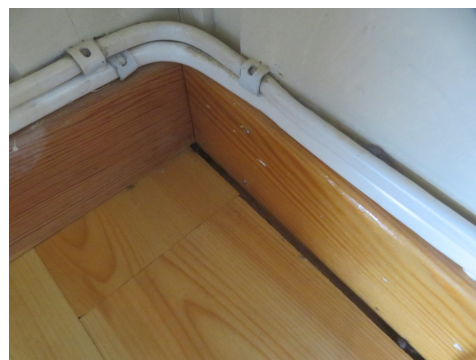
Klaring mellom laminatgulv og gulvlist i stue i 1. etg.
