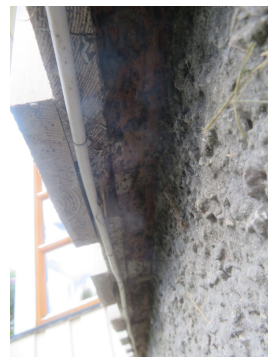
Lite lufting i nedkant av trepanel.
