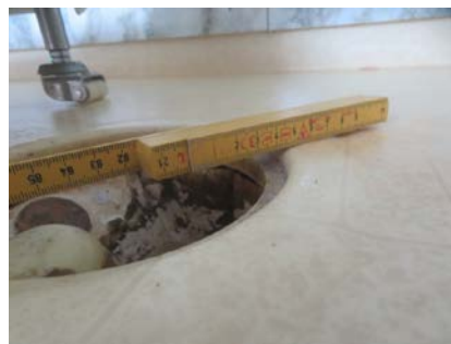
Belegget går opp rundt sluket.
