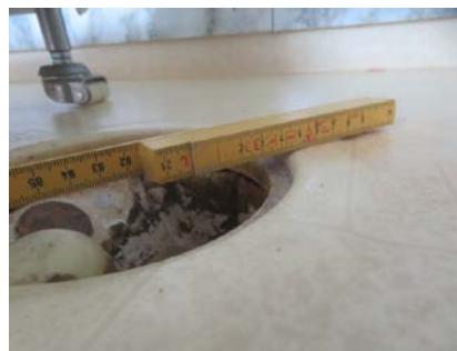
Belegget går opp rundt sluket.
