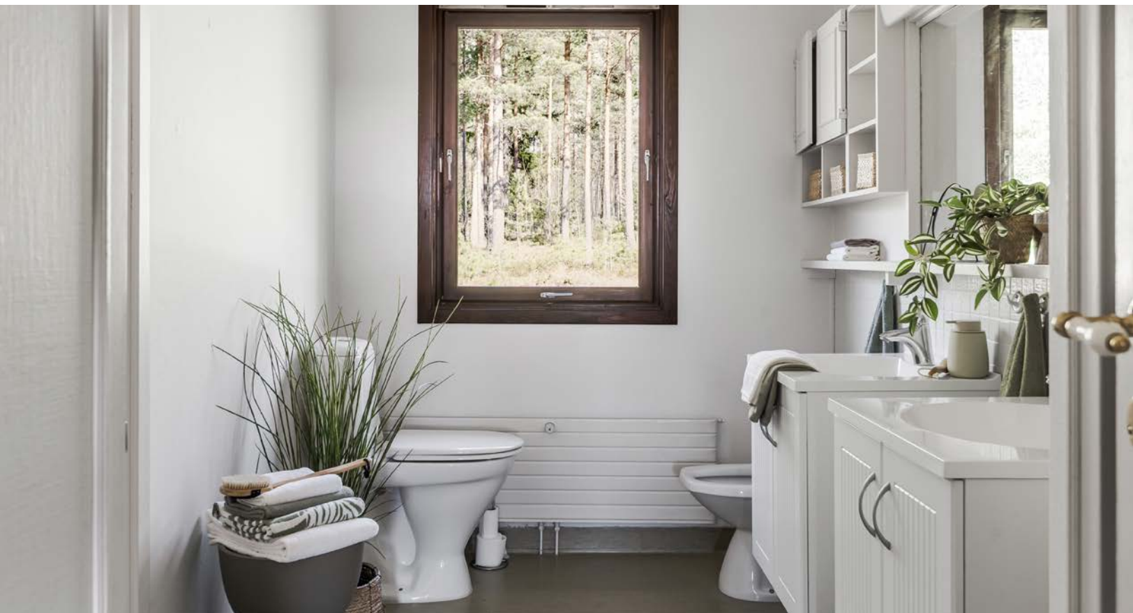
Baderom fra byggeåret med toalett, bide, to servanter, forheng, veggheingt dusj og dusjnisse.
