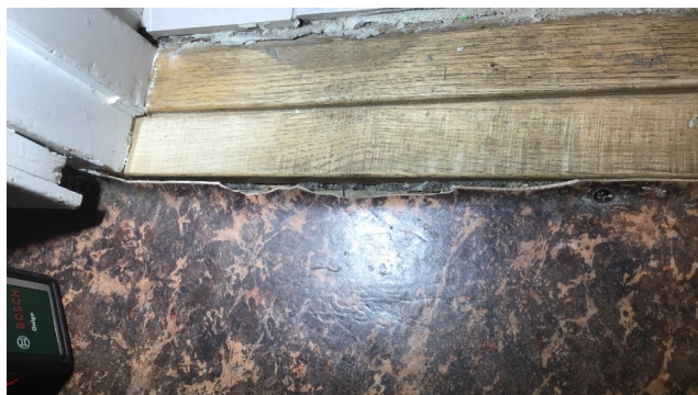
Utettheter i belegg langs dør
