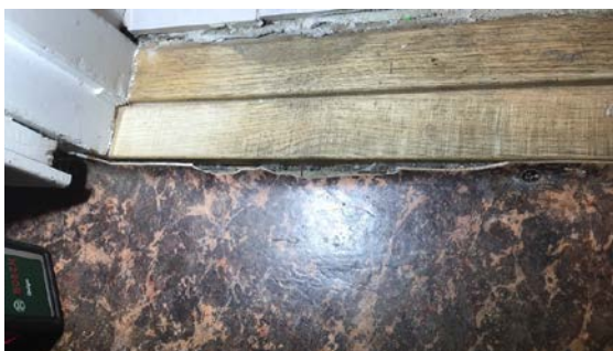
Utettheter i belegg langs dør
