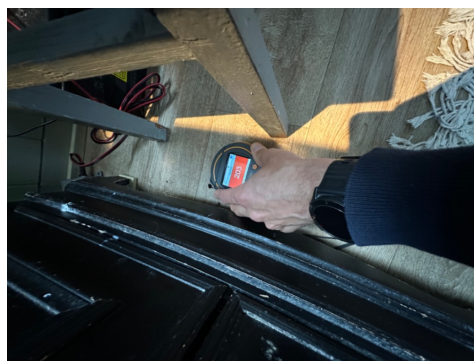
Fuktslag gulv toalettrom
