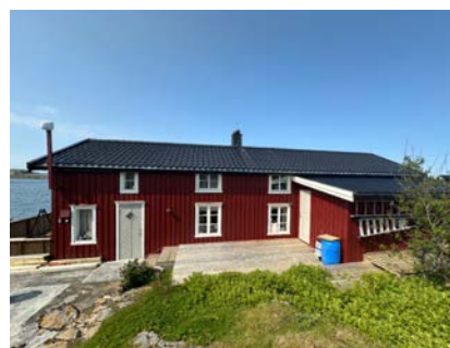
Tak besiktiget fra bakkenivå
