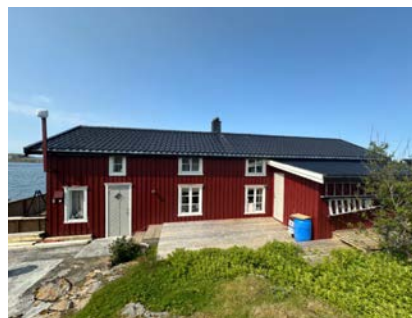
Tak besiktiget fra bakkenivå
