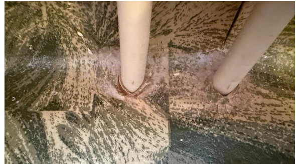
Utette rørgjennomføringer
