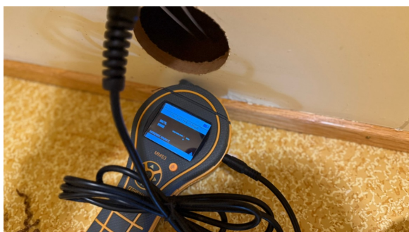
Fuktmåling i vegg inn mot vaskerommet
