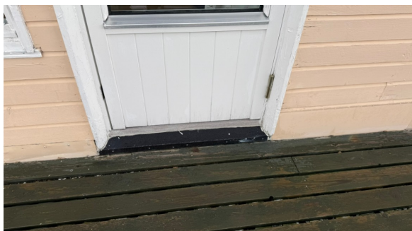
Utvendig side av balkongdøren
