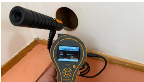
Fuktmåling i vegg mot badekaret
