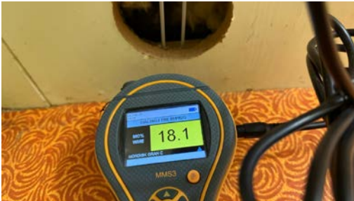
Fuktmåling i utforet vegg under terreng
