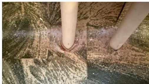
Utette rørgjennomføringer
