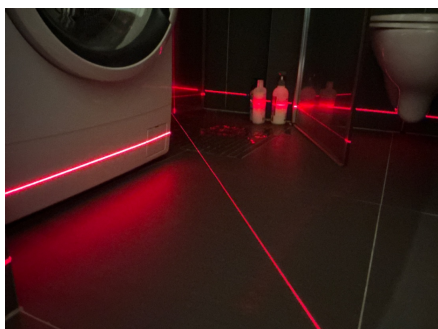
Fall på baderomsgulv er kontrollert med krysslaser.
