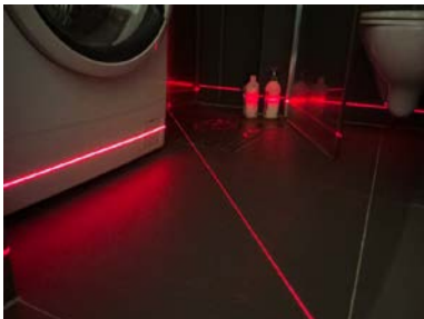
Fall på baderomsgulv er kontrollert med krysslaser.
