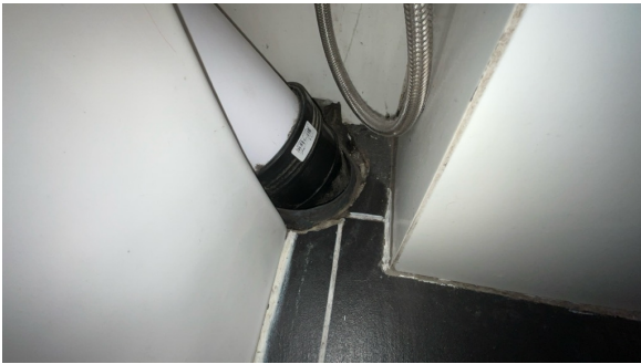
Åpning rundt toalettavløpet.
